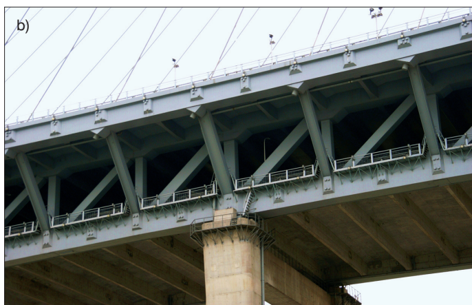
Fot. 70. Potężny most Minpu – najdłuższe przęsło nad Huangpu: a) widok pylonów i pomostu, b) szczegół oparcia przęsla kratowego na podporze pośredniej
