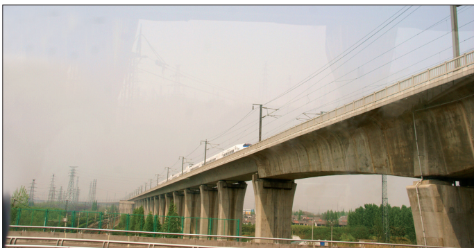
Fot. 81. Estakada na LDP nad drogą ekspresową Nankin-Szanghaj
