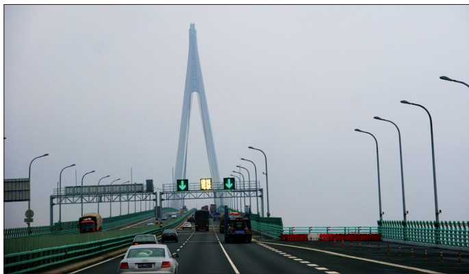
Fot. 73. Most jednopylonowy (jezdnia w kierunku Szanghaju)
