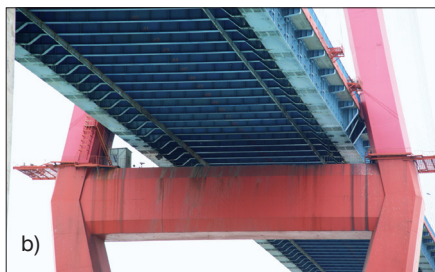
Fot. 67. Most Yangpu przez Huangpu: a) widok z równoległej do mostu ulicy, b) szczyt podpory
