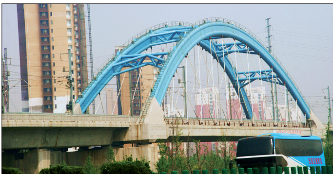
Fot. 82. Wiadukt kolejowy na LDP w systemie CFST (przy wjeździe do Jiangyin)
