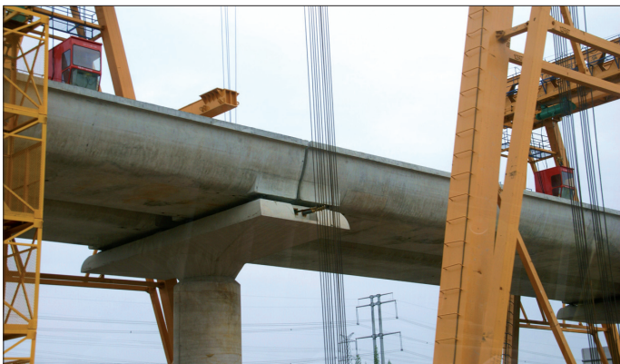
Fot. 83. Estakady kolei miejskiej (metra) w budowie (okolice Szanghaju)
