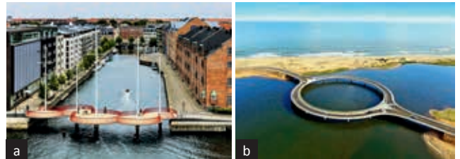
Ryc. 8: a) kładka dla pieszych Cirkelbroen, Kopenhaga, Dania, L = 40 m, otwierana część środkowa 25 m, 2015, maszty z odciągami nie są elementami konstrukcji, pełnią rolę dekoracyjną (np. przez wywieszanie flag), co trochę burzy ład strukturalny obiektu, b) okrągły most drogowy, jezioro Garzon, Urugwaj, R = 51,5 m, 2015
