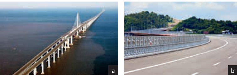
Ryc. 1. Najdłuższe trasy mostowe: a) na świecie – Qingdao Haiwan, Chiny, 42,58 km, 2011, b) w Polsce – estakada WE-1 w ciągu południowej obwodnicy Gdańska, 2,75 km, 2012 (fot. PORR SA)
