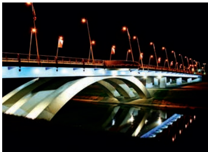
Ryc. 12. Most Zamkowy w Rzeszowie, L_1 = 50 m, 2002 (fot. Mosty Łódź SA)
