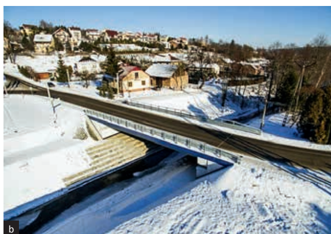
Ryc. 15: a) most o prześle z belek kompozytowych i żelbetowej płycie pomostu w Błażowej, L_1 = 21,00 m, 2015, b) most o prześle całkowicie kompozytowym w Nowej Wsi koło Rzeszowa, L_1 = 10,00 m, 2016 (fot. Mostostal Warszawa SA)
