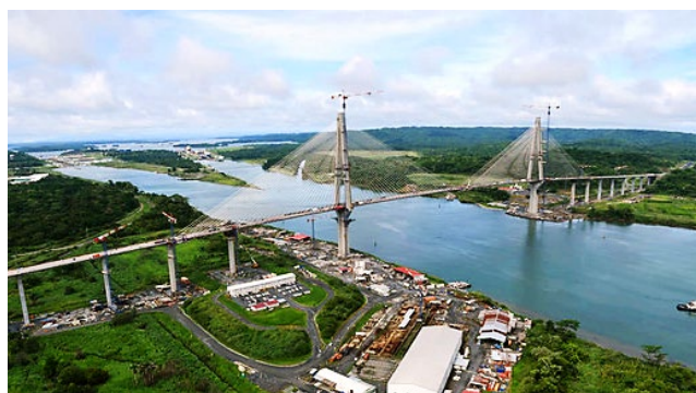
Ryc. 19. Atlantic Bridge przez Kanał Panamski, L_{\max} = 530 m, 2019 (w budowie)
