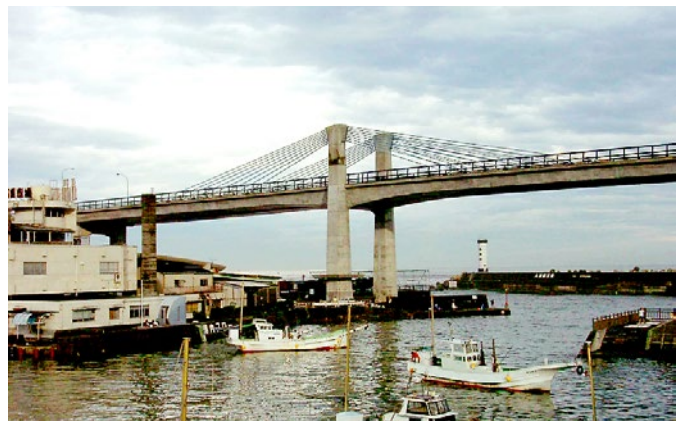
Ryc. 21. Pierwszy most o konstrukcji extradosed – most Odawara, Japonia, L_{\max} = 122 m, 1994
