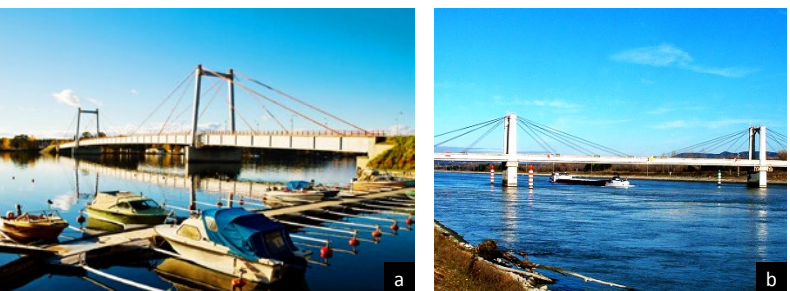
Ryc. 18. Pierwsze współczesne mosty podwieszono: a) stalowy most Strömsund, Szwecja, projekt Fritza Dischingera, L_{\max} = 182 m, 1953, b) betonowy most Donzère – Montdragon, Francja, projekt Alberta Caquota, L_{\max} = 81 m, 1952
