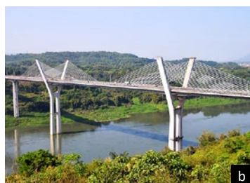
Ryc. 22. Rekordowe przęsła mostów extradosed: a) stalowe – most Wuhu, L_{max} = 312 m, 2000, b) betonowe – most Jiayue, L_{max} = 250 m, 2010
