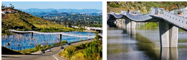
Ryc. 32. Kładka dla pieszych przez jezioro Hodges, San Diego, USA, L_{\max} = 3 \times 100,9 m, grubość pomostu 0,406 m, h/l = 1/249 , 2009
