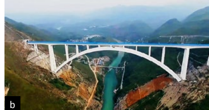
Ryc. 10. Rekordowe łukowe przęsła: a) stalowe – most Chaotianmen, L_{\max} = 552 m, 2009, b) betonowe – most Beipanjiang Qinglong, L_{\max} = 445 m, 2016, kolejowy
