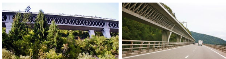
Ryc. 5. Wiadukt des Sylans, Francja, obiekty autostradowe z betonu sprężonego o konstrukcji kratownicowej, L_{max} = 1266 m, 1989. Tego rodzaju obiekty można także klasyfikować jako skrzynkowe konstrukcje belkowe o ażurowych środkach
