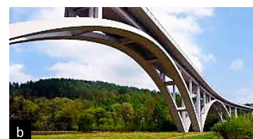
Ryc. 11. Rekordowe przęsła łukowe w Polsce: a) most im. Gen. Elżbiety Zawackiej przez Wisłę w Toruniu, L_{\max} = 270 m, 2013, b) most przez dolinę Kameszniczy w Milówce, L_{\max} = 130,84 m, 2006
