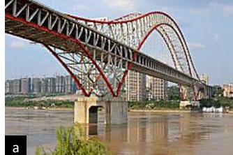
Ryc. 10. Rekordowe łukowe przęsła: a) stalowe – most Chaotianmen, L_{\max} = 552 m, 2009, b) betonowe – most Beipanjiang Qinglong, L_{\max} = 445 m, 2016, kolejowy
