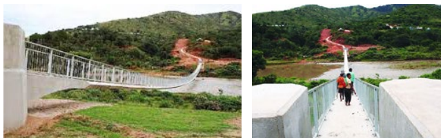
Ryc. 33. Betonowa kładka wstęgowa przez rzekę Mkomaas, Natal, Afryka, L_{\max} = 150 m, 2007
