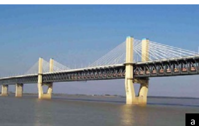
Ryc. 22. Rekordowe przęsła mostów extradosed: a) stalowe – most Wuhu, L_{max} = 312 m, 2000, b) betonowe – most Jiayue, L_{max} = 250 m, 2010
