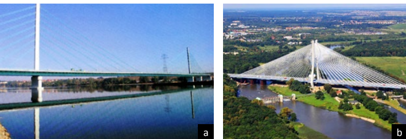
Ryc. 17. Rekordowe przęsła podwieszono w Polsce: a) stalowe – most Solidarności przez Wisłę, Płock, L_{\max} = 375 m, 2005, b) betonowe – most Rędzński przez Odrę, Wrocław, L_{\max} = 2 \times 256 m, 2011
