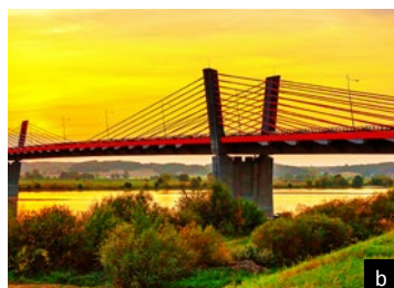
Ryc. 23. Rekordowe przęsła mostów extradosed w Polsce: a) most w ciągu DK16 w Ostródzie, L_{max} = 206 m, 2017, b) most przez Wisłę w Kwidzynie, L_{max} = 204 m, 2013
