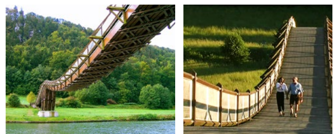
Ryc. 31. Drewniana konstrukcja wstęgowa mostu przez kanał Men - Dunaj w pobliżu Essing, Niemcy, rozpiętości przęsła 30 m + 32 m + 73 m + 35 m = 192 m, 1987
