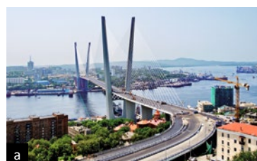
Ryc. 16. Rekordowe przęsła podwieszane: a) stalowe – most we Władywostoku, L_{max} = 1104 m, 2012, b) betonowe – most Skarnsundet, L_{max} = 530 m, 1991
