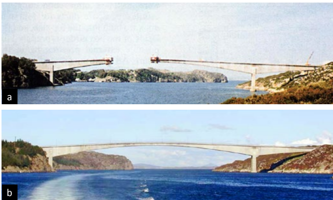
Ryc. 2. Most Stolmasundet, Norwegia, L_{\max} = 301 m, 1998: a) podczas budowy przęsła metodą betonowania nawisowego, b) ukończony most
