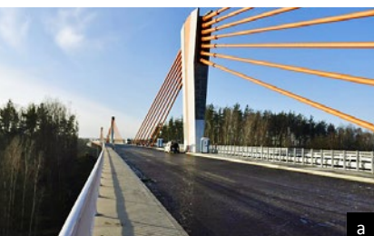
Ryc. 23. Rekordowe przęsła mostów extradosed w Polsce: a) most w ciągu DK16 w Ostródzie, L_{max} = 206 m, 2017, b) most przez Wisłę w Kwidzynie, L_{max} = 204 m, 2013
