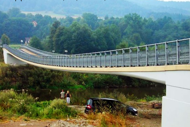
Ryc. 35. Kładka pieszo-jezdna przez Rabę w Luboniu, L_{\max} = 91,40 m, rozpiętość w świetle 71,40 m, h/l = 1/150 , 2011
