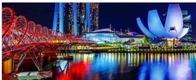
Ryc. 9. Kładka dla pieszych w Singapurze wzorowana na pętli DNA, Helix Bridge, L_{\max} = 280 m, 2010
