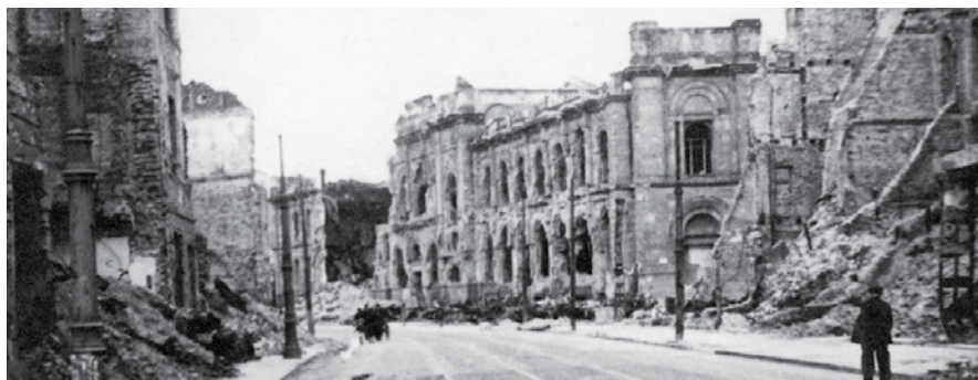
Zniszczona siedziba Banku Polskiego SA przy ul. Bielańskiej
