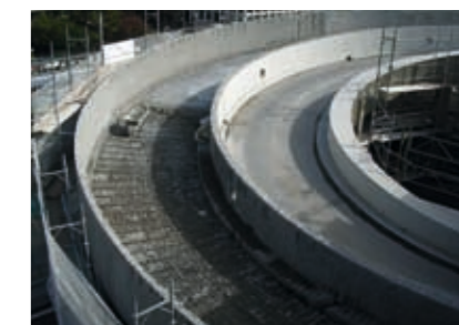
Konserwacja i naprawa betonu Strona 24
