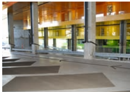
Posadzki i powłoki ochronne Strona 8
