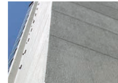
Uszczelnienia na elewacjach i między elementami prefabrykowanymi Strona 21
