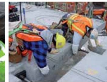
Łączenie konstrukcyjne i iniekcje
