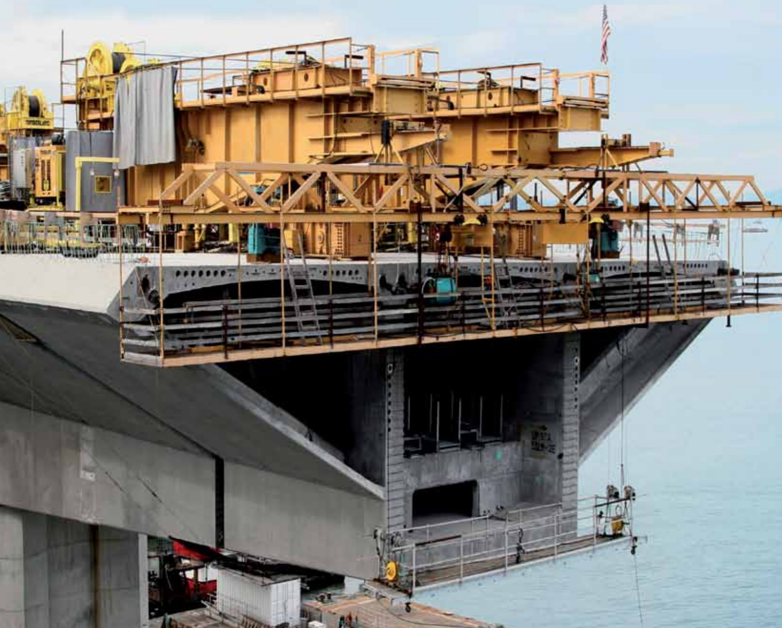
Klejenie konstrukcyjne elementów mostu segmentowego, Oakland Bay Bridge, San Francisco, USA
