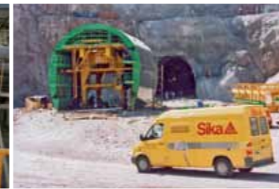
Dostawa na budowę
