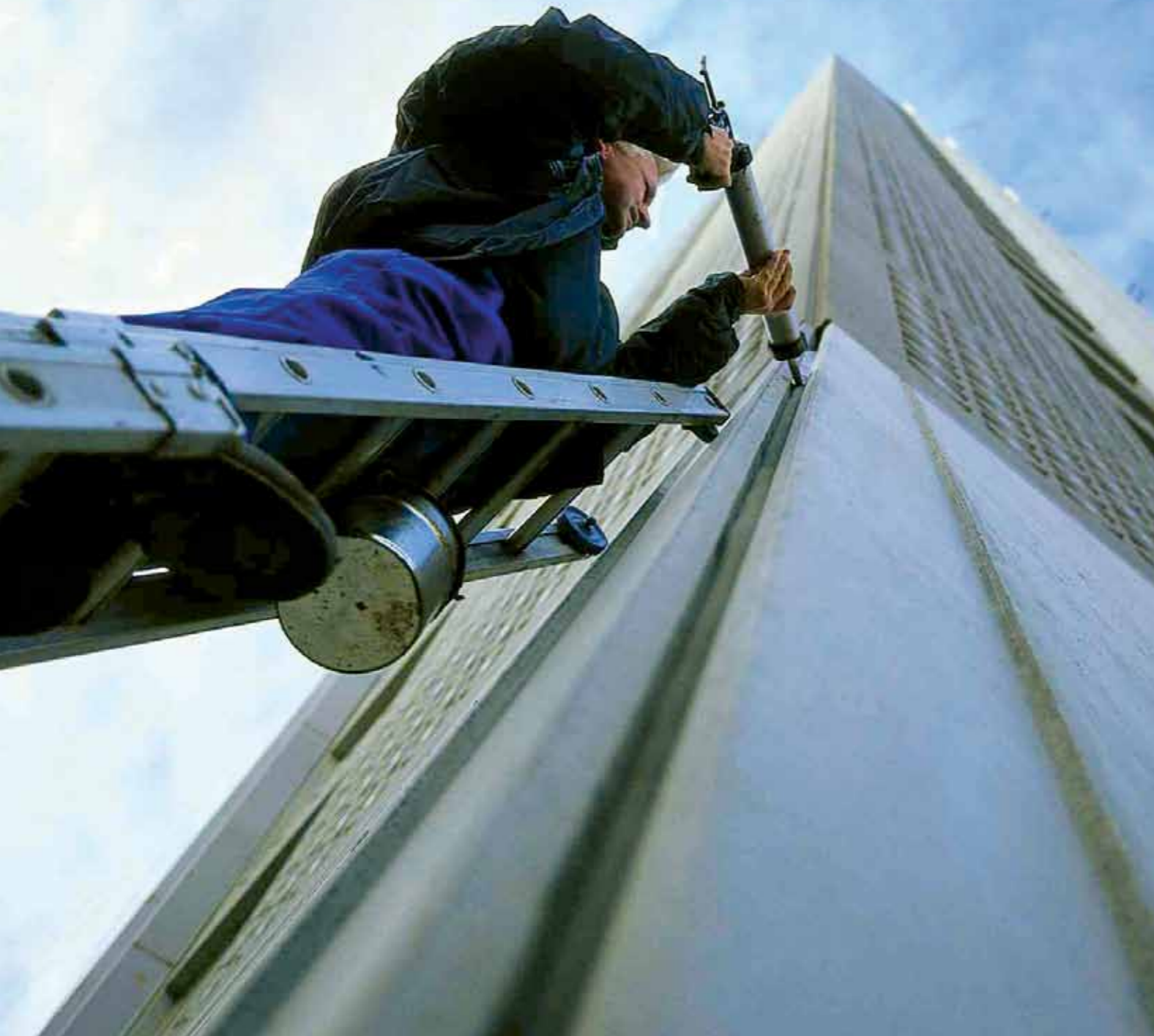
Rozwiązanie uszczelnienia budynku biurowego, Kanada
