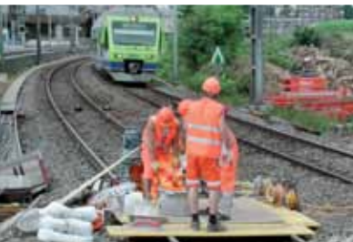
Podlewka płyty stalowej
