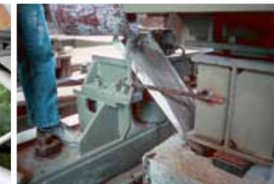
Podlewka pod podstawę maszyny
