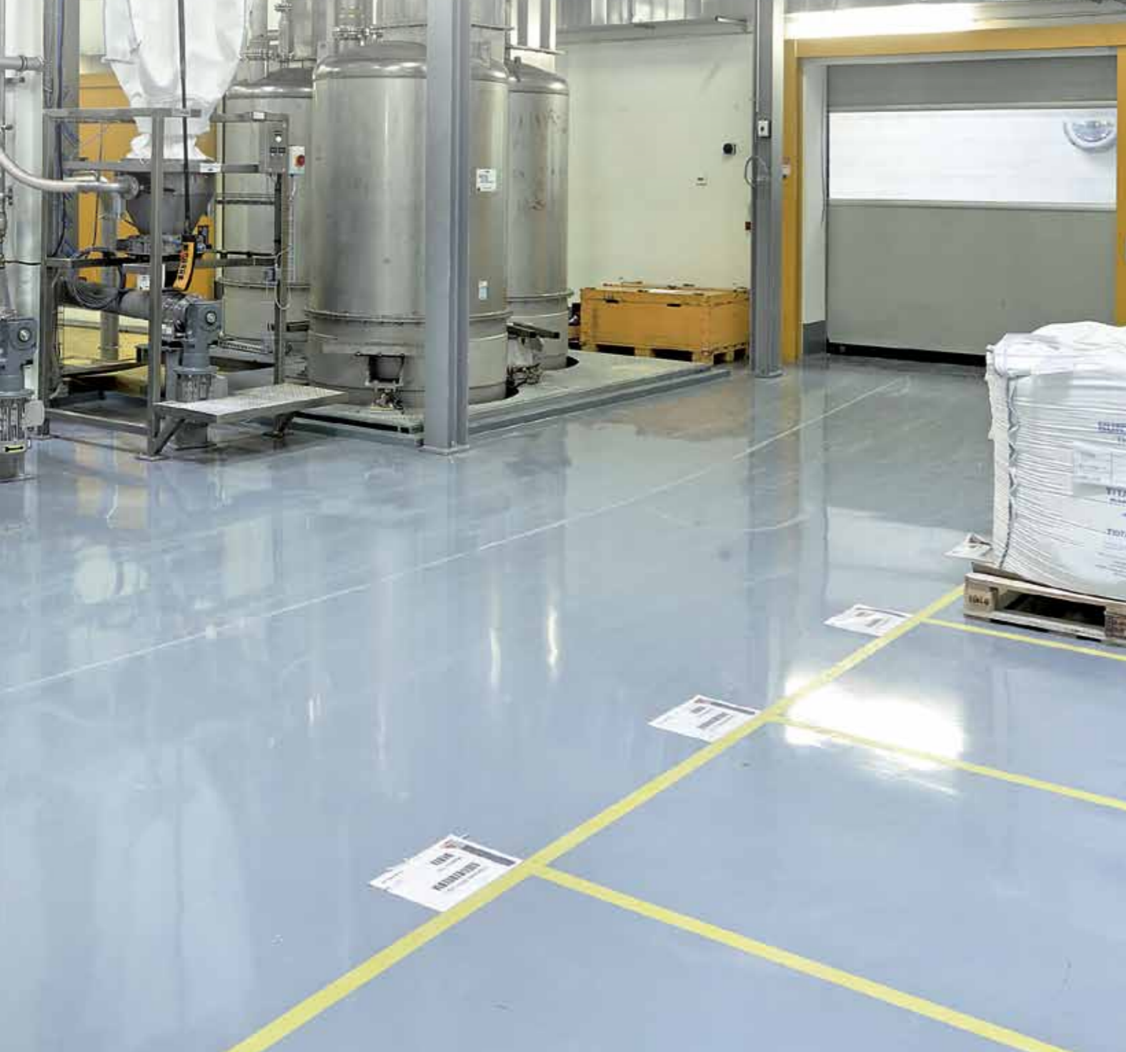
Rozwiązanie posadzki przemysłowej w zakładzie Sika produkcji poliuretanów, Werk Kapaflex, Düringen, Szwajcaria
