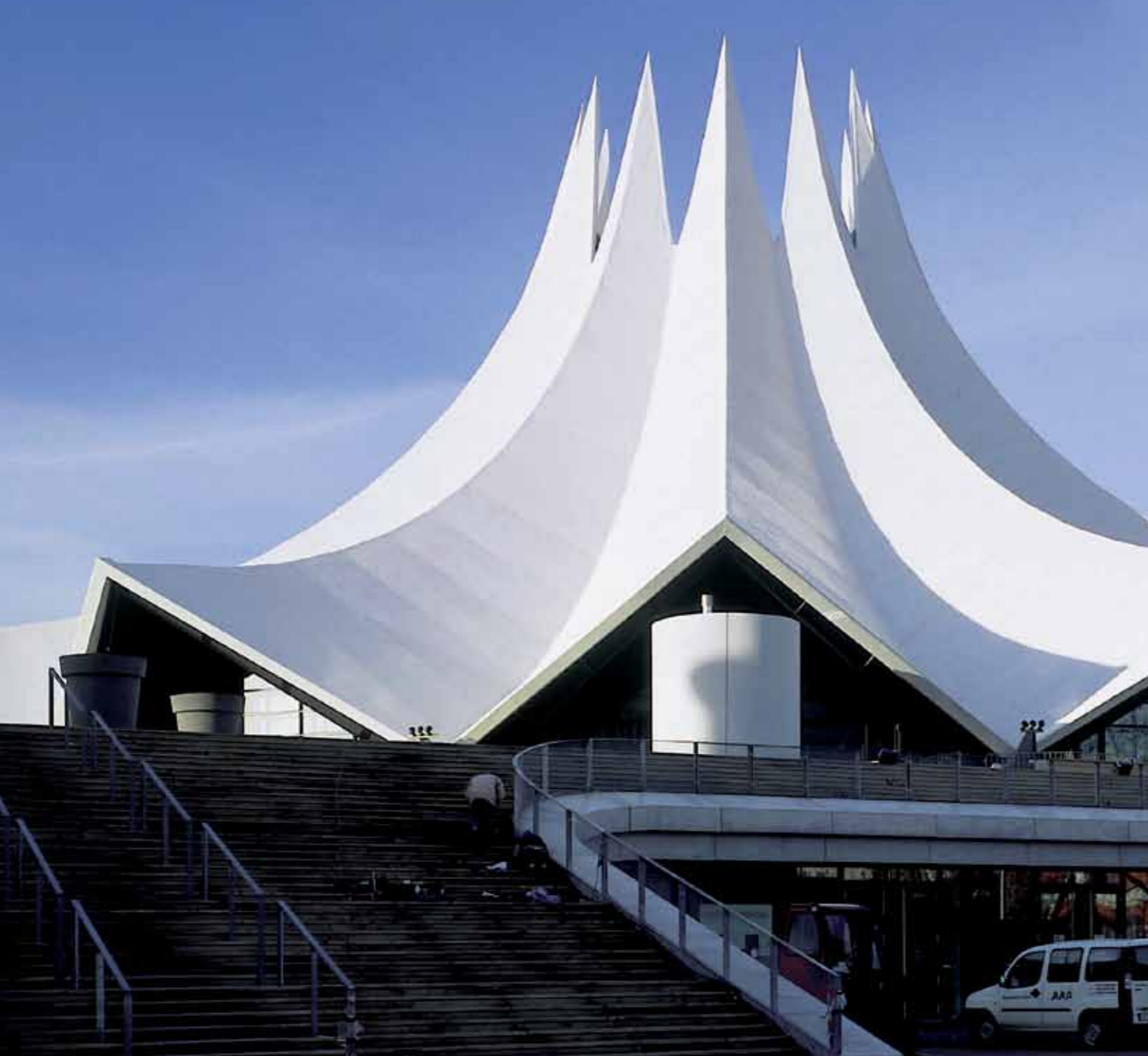
Krzywoliniowy dach pokryty mechanicznie mocowaną membraną Sarnafil® Tempodrom, Berlin, Niemcy
