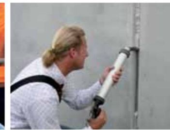
Uszczelnianie przerw i dylatacji
